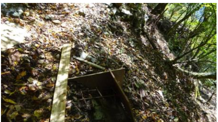
型枠を組み立てる
