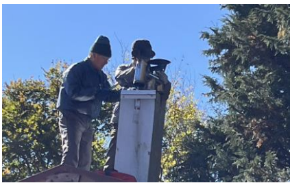
煙突改良作業
