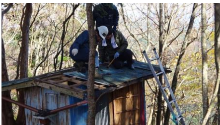
トイレ棟の工事
