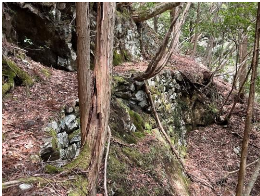
石積みの道が随所に残っている
