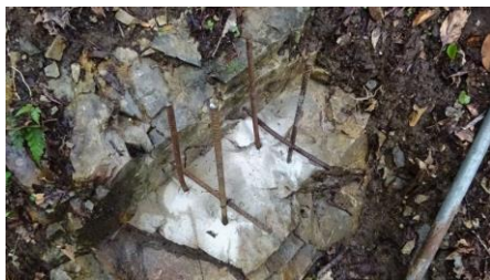
鉄筋を打ち込み
