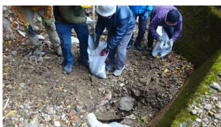
溜まった土砂を掘る
