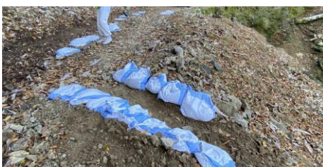
排水路を掘った
