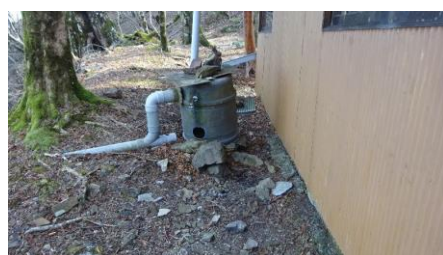
雨水槽の水抜き
