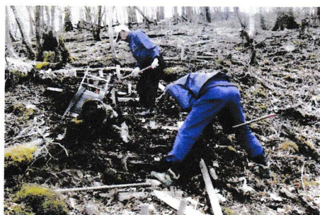
▲奥駈道修復作業
