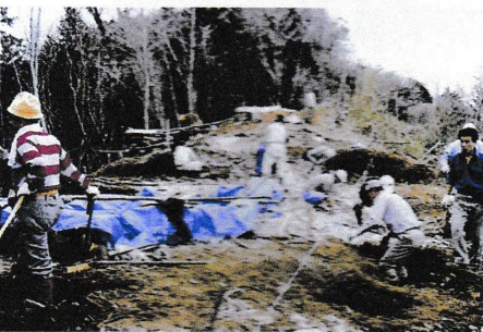
▲行仙宿建設前の敷地造成
